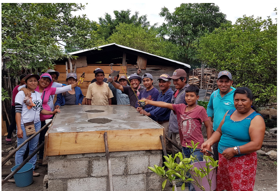
Construction collective d'une latrine écologique, 2019 © Madre Tierra México
