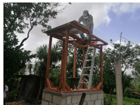
Construction d'une latrine à El Naranjo, juillet 2020 @ACCODIL
