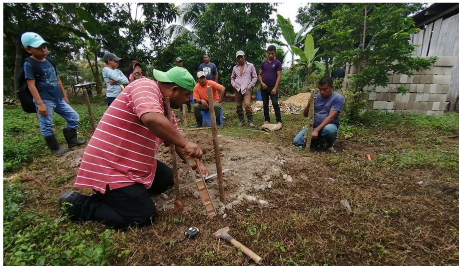
Prise des mesures pour la construction de latrines à Guayacán, novembre 2020,
