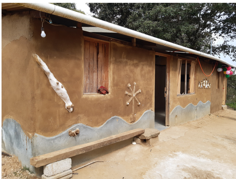
Inauguration d'une maison rebâtie en dur par MTM, avec de nouvelles techniques et un toit en tôle laissant passer la lumière, communauté El Palmar, 28.10.2025 ©AM
